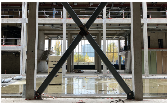
Scellement de croix de contreventement
