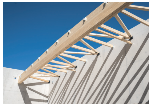
murs grande hauteur gymnase
